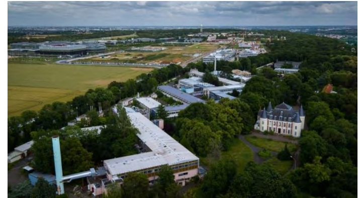
Vue aérienne, ZAC de Corbeville avec le Château de Corbeville. Photographie : epaps.fr
